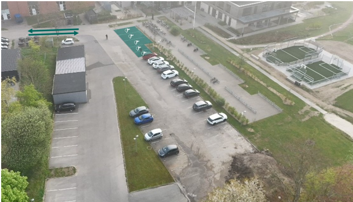
Figur 7 Overblik over den nordvestlige parkeringsplads.
