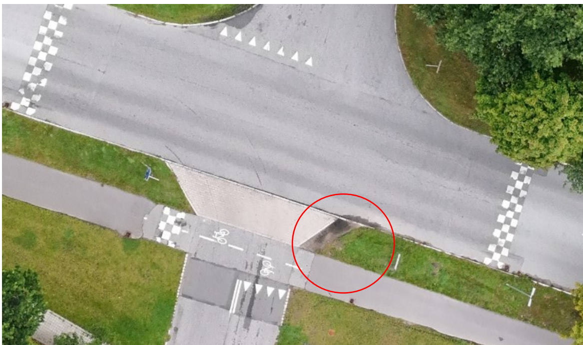
Figur 25 Markering af areal, som højresvingende cyklister kører over grundet for skarp vinkel.
